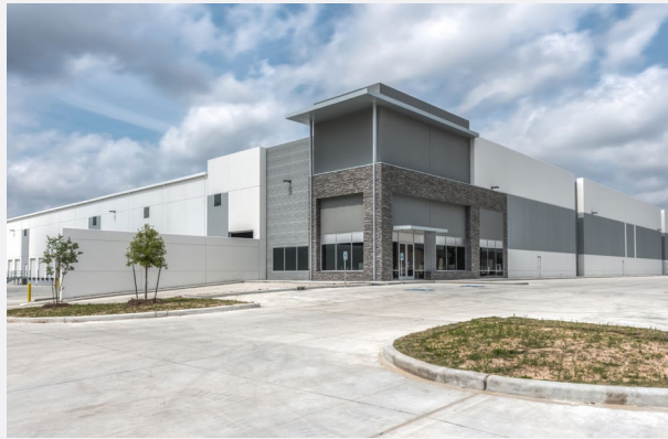
// PARC AIR 59 HOUSTON, TEXAS
