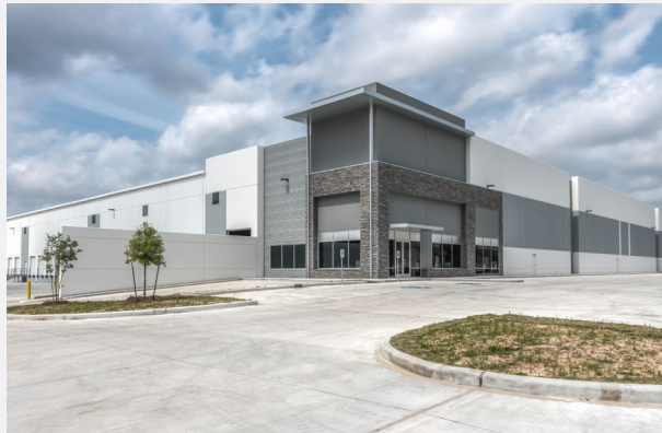
// PARC AIR 59 HOUSTON, TEXAS
