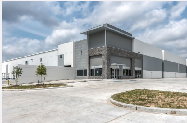
// PARC AIR 59 HOUSTON, TEXAS
