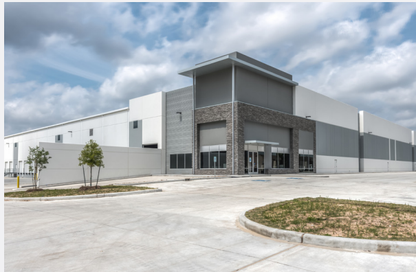
// PARC AIR 59 HOUSTON, TEXAS
