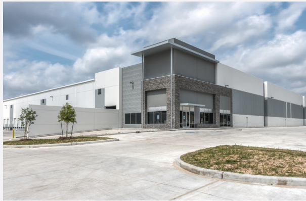
// PARC AIR 59 HOUSTON, TEXAS
