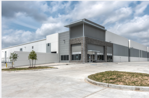
// PARC AIR 59 HOUSTON, TEXAS
