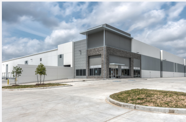
// PARC AIR 59 HOUSTON, TEXAS
