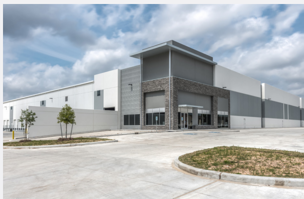
// PARC AIR 59 HOUSTON, TEXAS
