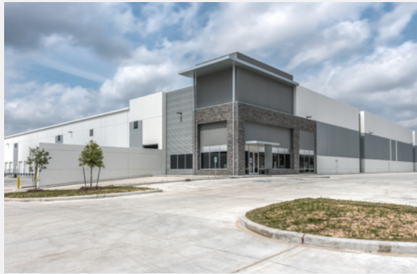
// PARC AIR 59 HOUSTON, TEXAS
