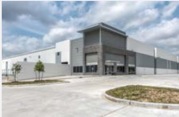
// PARC AIR 59 HOUSTON, TEXAS
